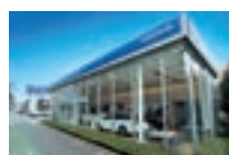
ボルボ・カーズ福岡西
