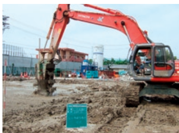
深層混合機吐出混合工法
