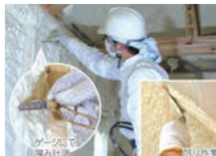
断熱に必要な適切な厚みの測定
